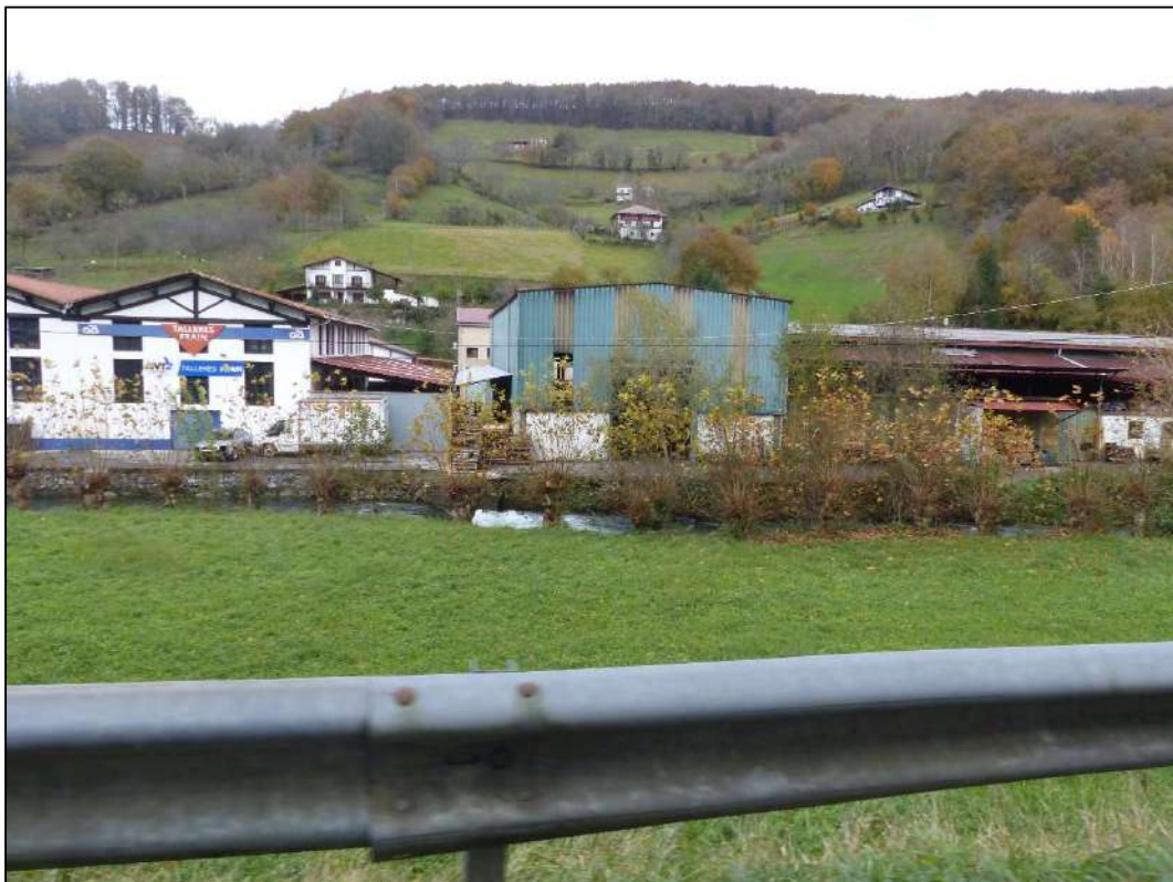
Figura 45. Fotografías tomadas en la zona del polígono industrial que se encuentra en la parte más aguas abajo del cauce del río Biurrana a su paso por el casco urbano de la localidad. La tercera fotografía muestra las alcantarillas situadas a menor cota en esta zona.
