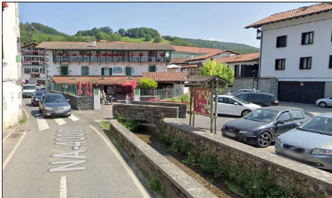
Figura 20 Imagen del puente sobre la regata de la zona de la calle Bittiria. La regata circula canalizada y bajo diversas edificaciones durante todo este tramo en el que los posibles desbordamientos afectarían tanto a la carretera NA-4000, como a diversas calles y a la zona de aparcamiento mostrada en esta imagen. El puente peatonal sobre la regata supone el mayor limitante de capacidad hidráulica de la regata en esta zona. El punto mostrado en esta imagen aparece señalado con la ubicación [2] en la imagen 19.
