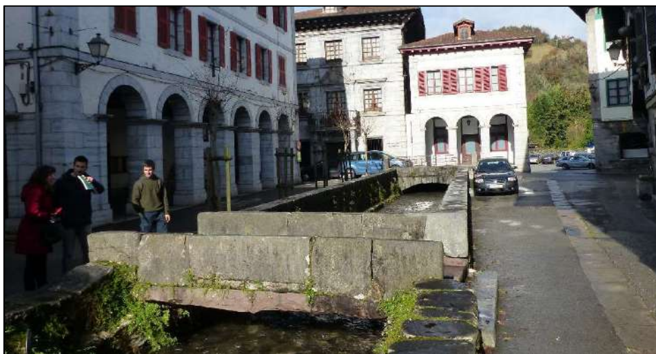
Figura 18 Zona del tramo de la regata Onin que atraviese la zona urbana de Lesaka.
