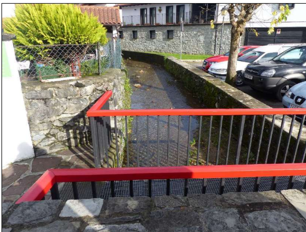
Figura 43. Fotografías del cauce canalizado de una regata menor a su paso por el centro del casco urbano de la localidad. La segunda fotografía ilustra el paso del puente peatonal sobre la regata en esta zona del municipio [Bittiria kalea].
