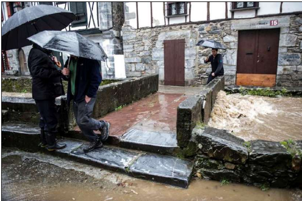
Figura 24 Fotografía tomada durante una inundación anterior, del inicio de los desbordamientos de la regata Onin, a la altura de Beheko Plaza, debido a la baja capacidad de hidráulica de los puentes peatonales de la zona. Fuente Argazki Press.
