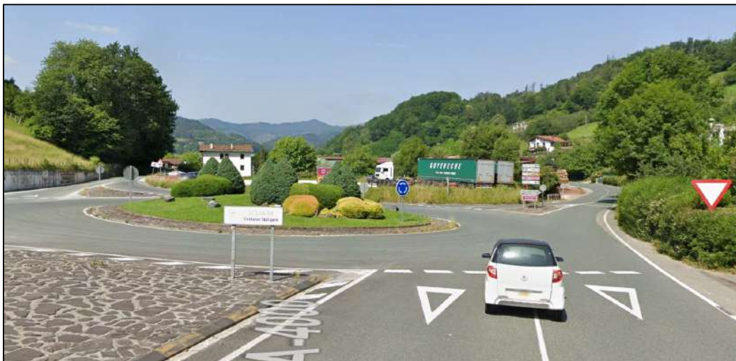
Figura 27 Fotografía de la carretera NA-4000, en la rotonda que da acceso al casco urbano de Lesaka, procedente de la carretera N-121-A. Este tramo con riesgo de verse inundado aparece señalado con el número [3] en la figura 26. En la parte derecha de la imagen se ve la carretera NA-4001 que sale de la rotonda para dirigirse a la entrada de la fábrica de ArcelorMittal y al parque de bomberos de Lesaka.
