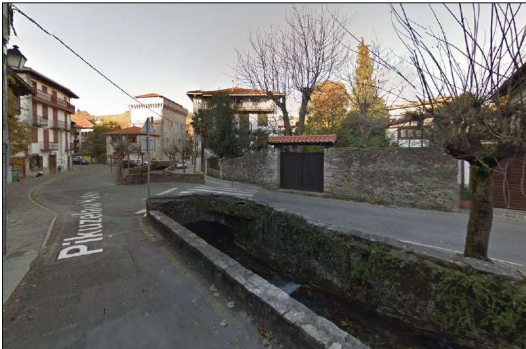
Figura 21 Imágenes de diversos puentes que salvan el cauce de la regata Onin en la zona de la calle Pikuzelaia. En concreto la imagen superior muestra el primer tramo de la regata en su entrada en el casco urbano. Se trata de una vista desde el puente de la calle Ote, hacia aguas arriba de la regata.
