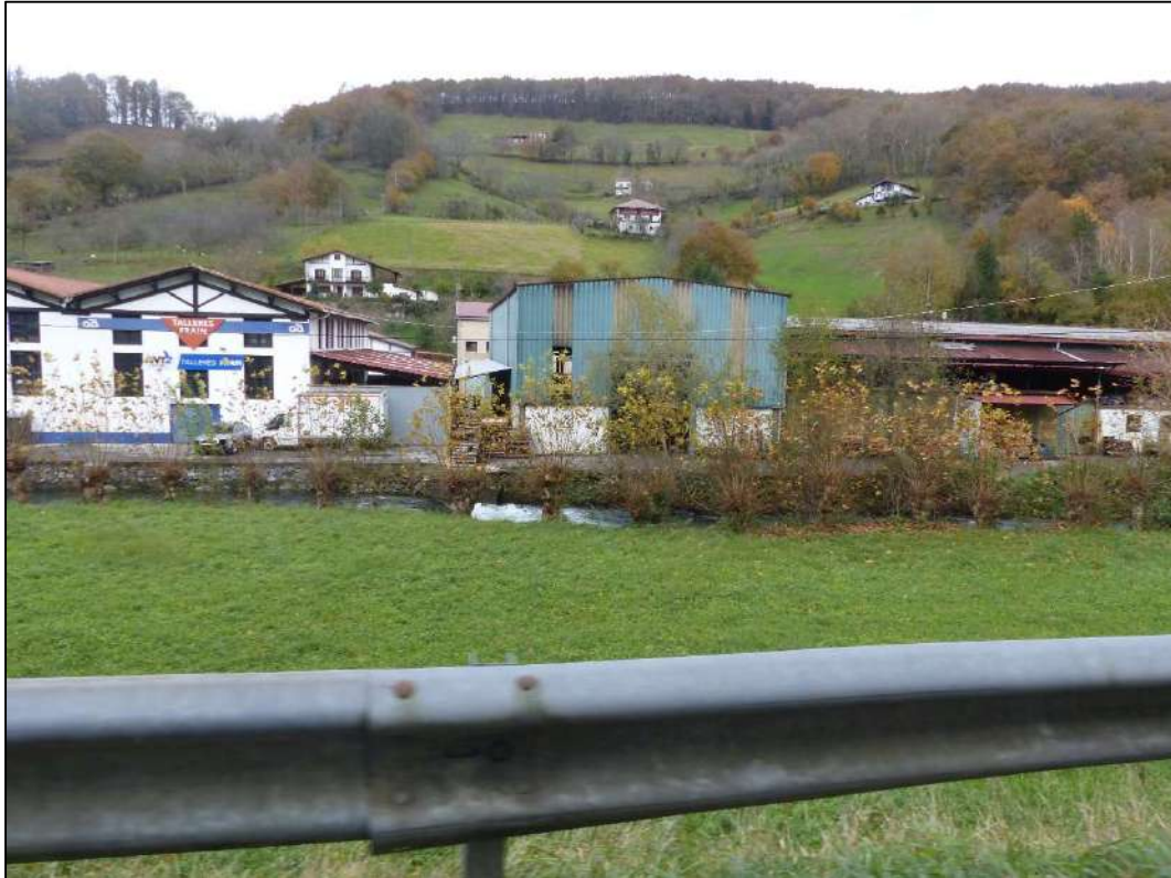
Figura 25 Fotografía tomada durante la vista de campo, de la zona del polígono industrial situado en la parte aguas abajo del cauce del Biurrana, en su margen izquierdo. Los desbordamientos en esta zona pueden dar lugar a inundaciones importantes de la zona industrial, debido a la dificultad del alcantarillado para evacuar el agua desbordada al encontrarse el nivel del río en cotas muy altas durante una avenida.
