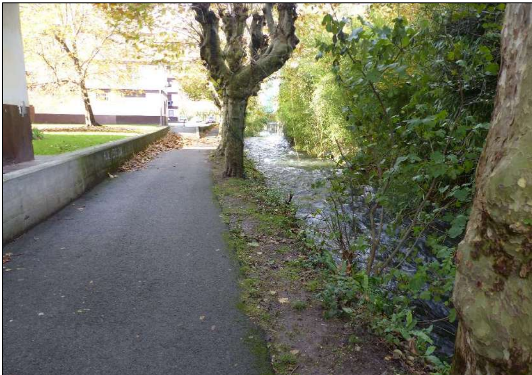
Figura 42. Fotografías tomadas del cauce del Bierrana, en la zona alta del casco urbano de Lesaka, en la zona donde se encuentra el paso peatonal que da acceso a la fábrica situada en la margen izquierda del río.
